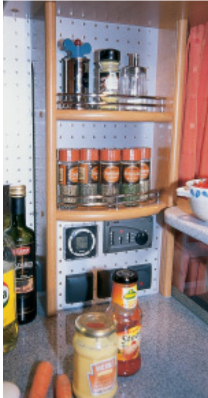
Gut zugänglich: die Bedienelemente der Heizung.
